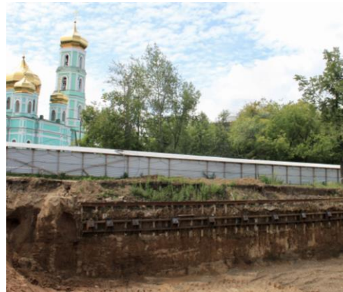
ЖК с подземным паркингом г. Пермь, устройство ограждения котлована
