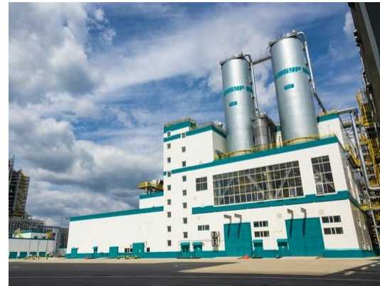
«Сибур Тобольск» г. Тобольск, финишная бетонная стяжка пола с упрочненным верхним слоем
