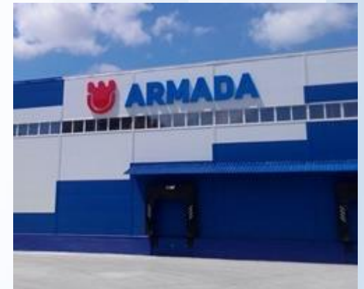
Логистический терминал ARMADA г. Хабаровск, перегрузочное оборудование
