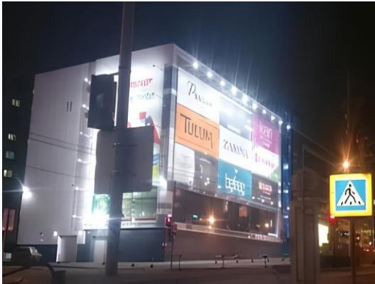
ТЦ «Айсберг» г. Пермь, наружное освещение
