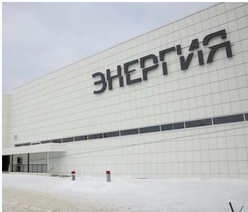
МФСК «Энергия» г. Пермь, металлоконструкции
