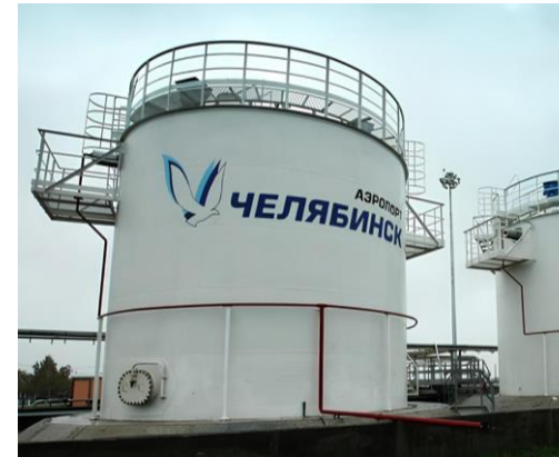
Международный аэропорт «Курчатов» г. Челябинск, АКЗ резервуаров
