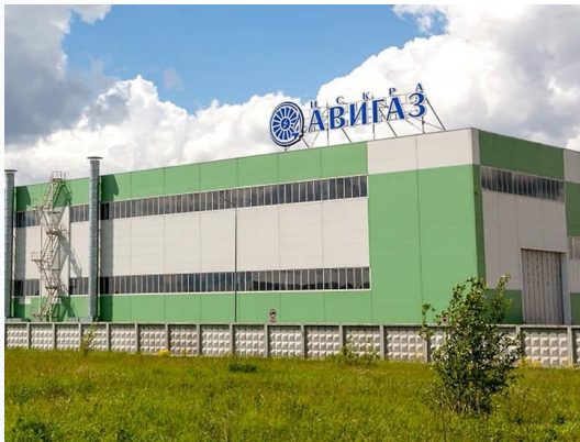
«Искра-Авигаз» г. Пермь, бетонные полы с покрытием «Кородур-Коротан»
