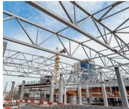
ТРЦ «iMall» г. Пермь, металлоконструкции
