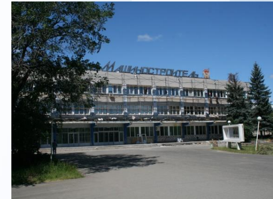
ПЗ «Машиностроитель» г. Пермь, реконструкция пола производственных помещений. Устройство железобетонного пола с упрочненным верхним слоем
