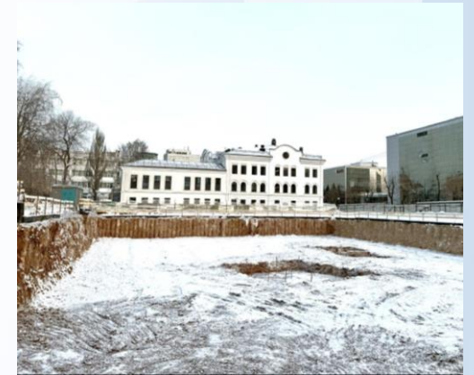
ЖК с подземным паркингом г. Пермь, устройство ограждения котлована
