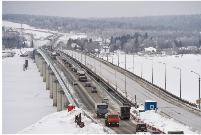
Мостовой переход, р. Чусовая Автодорога Пермь – Березники
