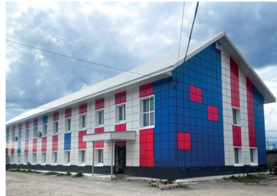
ООО «Водоканал» г. Соликамск, навесной вентилируемый фасад АБК
