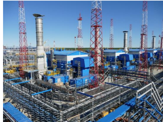
АО «Газпром» производство зданий-укрытий для размещения ГПА
