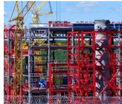
ПАО «Метафракс» г. Губаха, металлоконструкции
