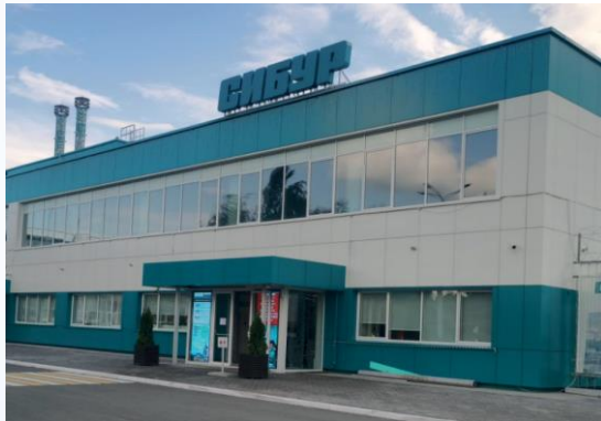
АО «Сибур-Химпром» г. Пермь, фасад АБК
