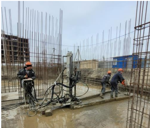
ЖК, высотная застройка г. Краснодар, укрепление грунта под плитой
