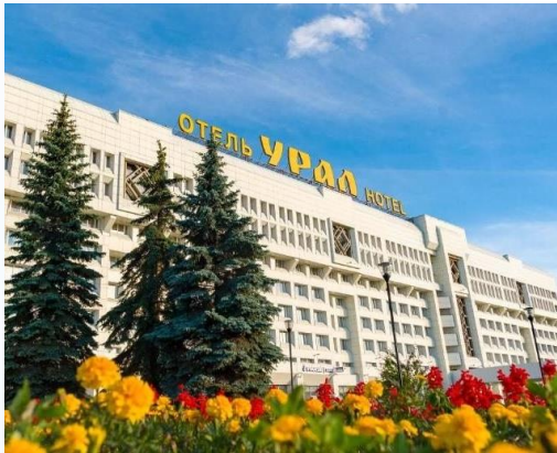
Гостиница «Урал» г. Пермь, ремонт первого этажа
