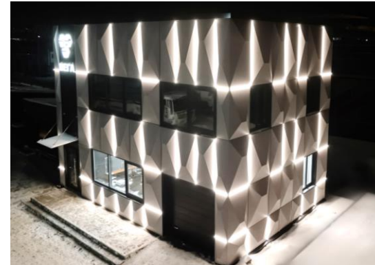
ООО «Бетонный завод «Вега» г. Пермь, офисное здание из ЛСТК с вент. фасадом
