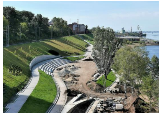
Городская набережная г. Пермь, поставка товарного бетона
