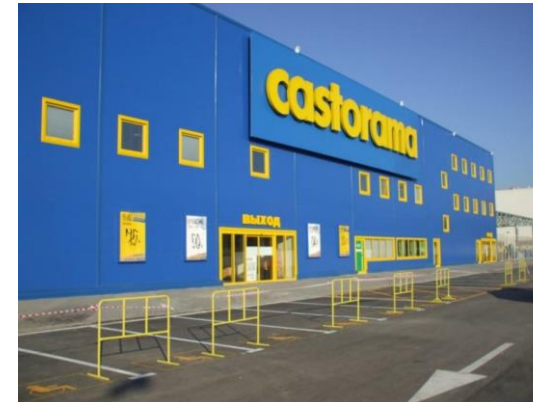
ТЦ «Castorama» г. Пермь, устройство полов с топпинговым покрытием
